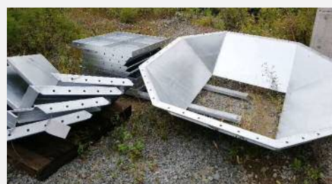
約15tの重錘作成用の型枠材
