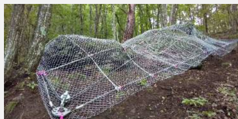
・クロスコントロールネット(長野県)
