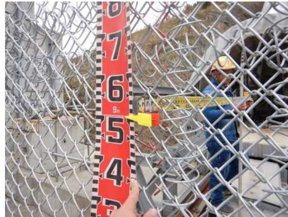
重錘衝突位置確認
