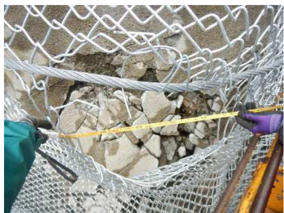
重錘衝突部の損傷状況
