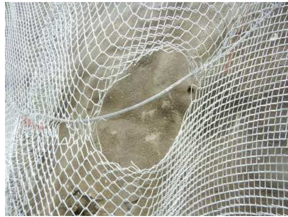
重錘衝突部の損傷状況
