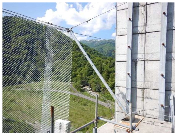
支柱設置状況
