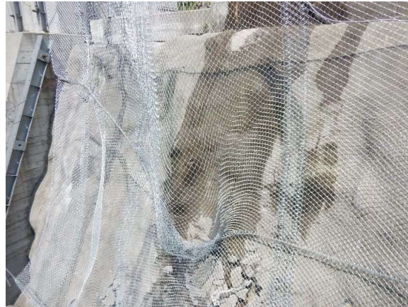
重錘衝突部の損傷状況
