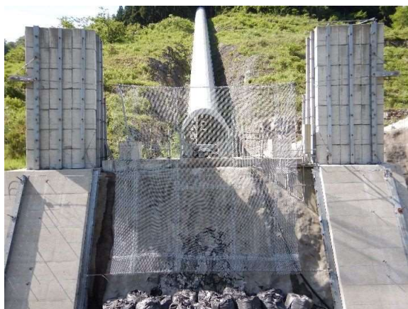
実験供試体全景
