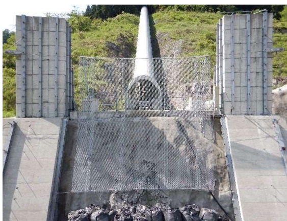
実験供試体全景
