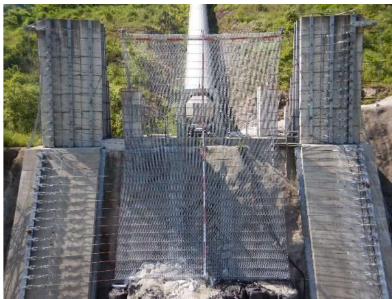
実験供試体全景
