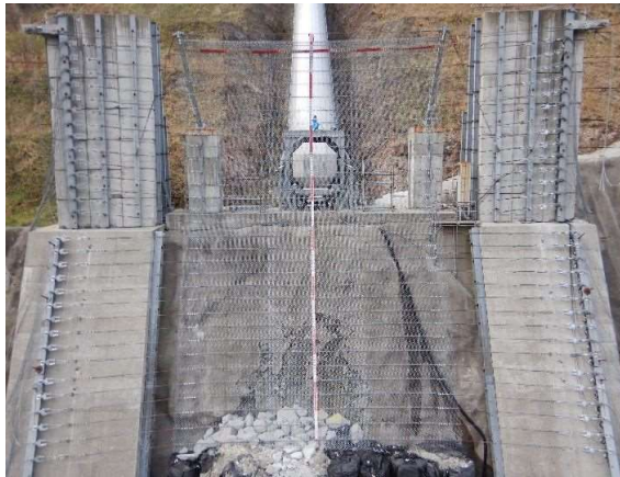
実験供試体全景
