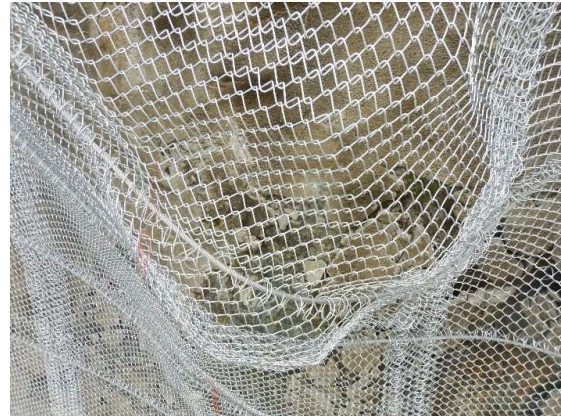
重錘衝突部の損傷状況
