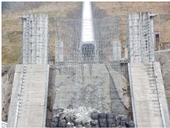
捕捉誘導後の全景
