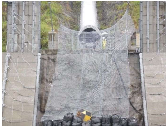
捕捉誘導後の全景
