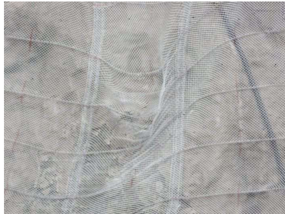
重錘衝突部の損傷状況
