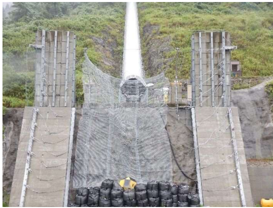
捕捉誘導後の全景
