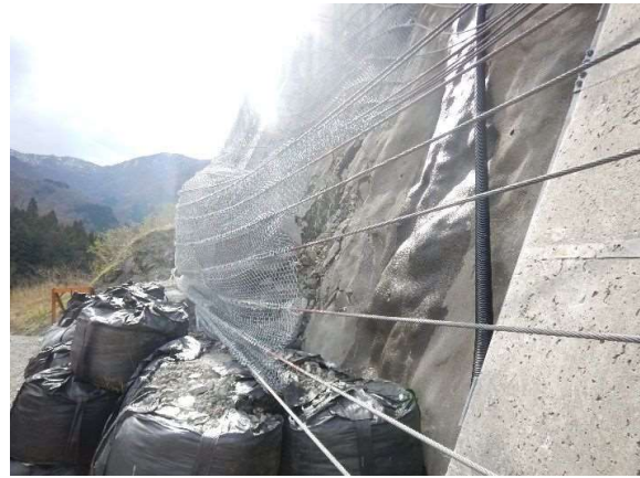
重錘捕捉状況
