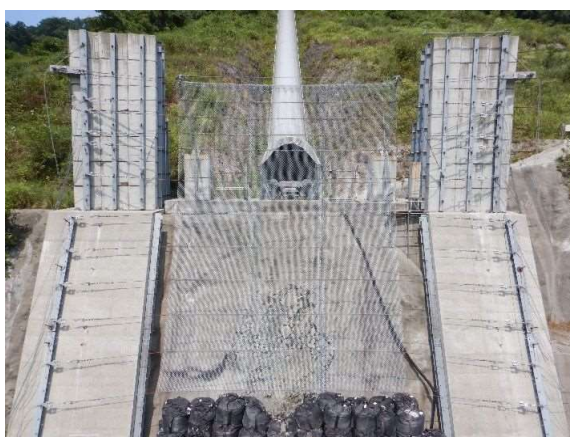
実験供試体全景
