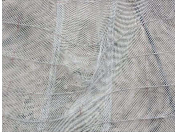
重錘衝突部の損傷状況
