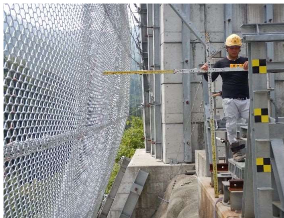
重錘衝突位置確認
