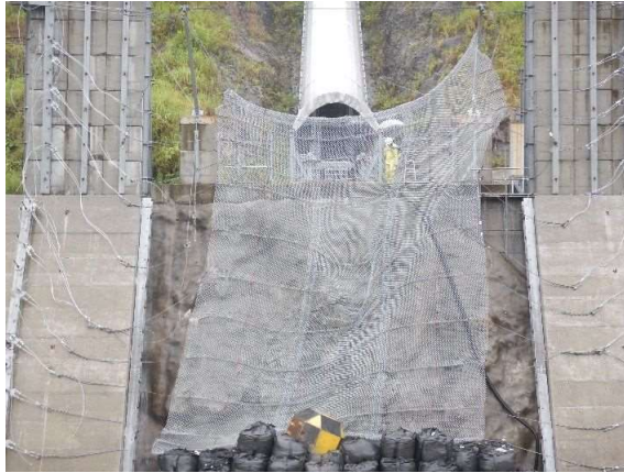
捕捉誘導後の全景
