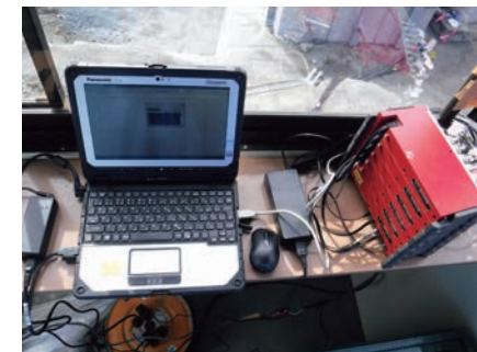
張力測定用計測器設置状況
