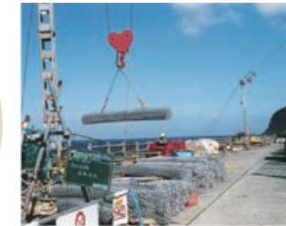
ケーブルクレーン
