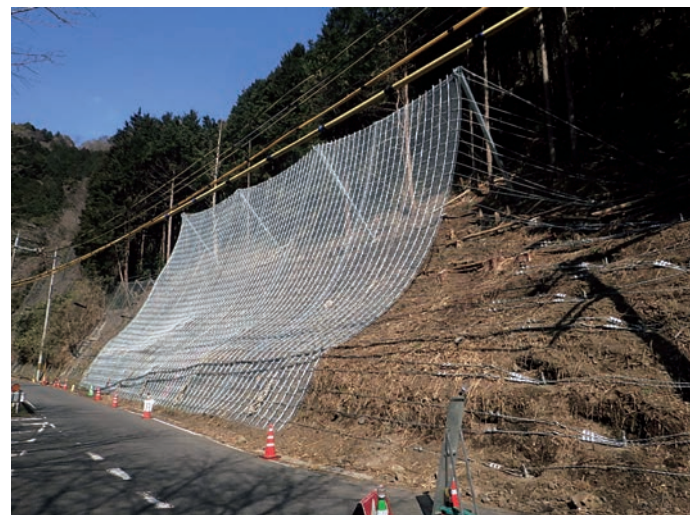
工事名：管内一円(和束井手線) 平成30年発生土災害復旧工事 発注者：京都府山城北土木事務所
