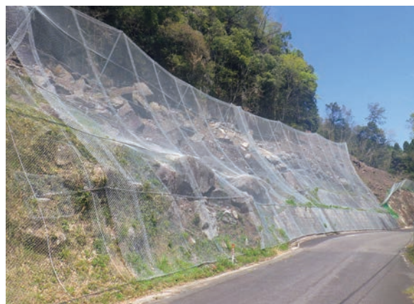
KB-NH4.0-1型 施工事例（2スパン） ・設置高さは①18m②18m ・設置延長は①30m②34m ・支柱間隔は①10m②11m×2,12m ・支柱本数は①3本②3本
