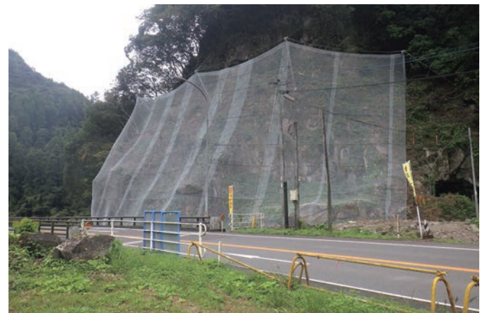
高エネルギー吸収型ポケット式落石防護網（支柱間隔が広い）
