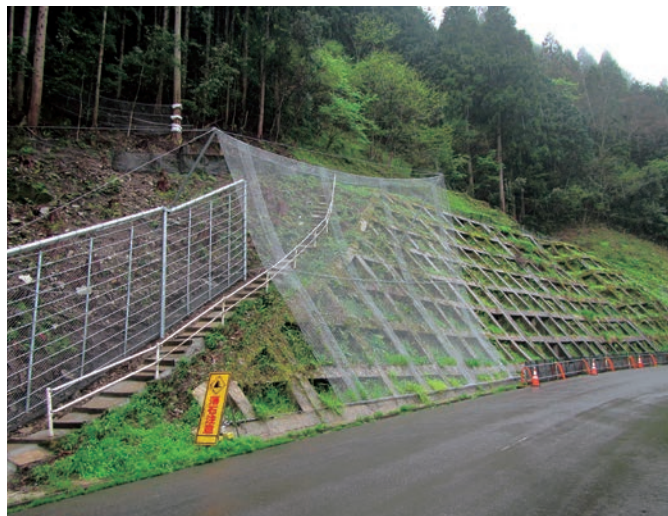
工事名：令和2年度明許繰越 社会資本整備総合交付金事業 (災害防除)町道三島三谷線工事 発注者：川本町(島根県)
