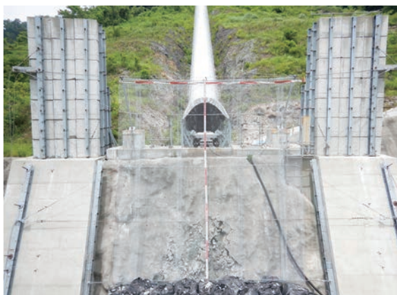
KB-NH4.0-1型実験供試体 ・設置高さは11m ・設置延長は10m ・支柱間隔は10m ・支柱本数は2本
