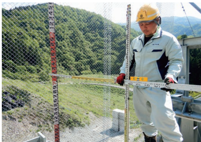
載荷位置測定状況
