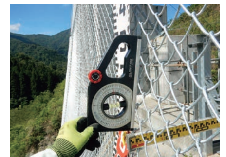
阻止面設置角度確認
