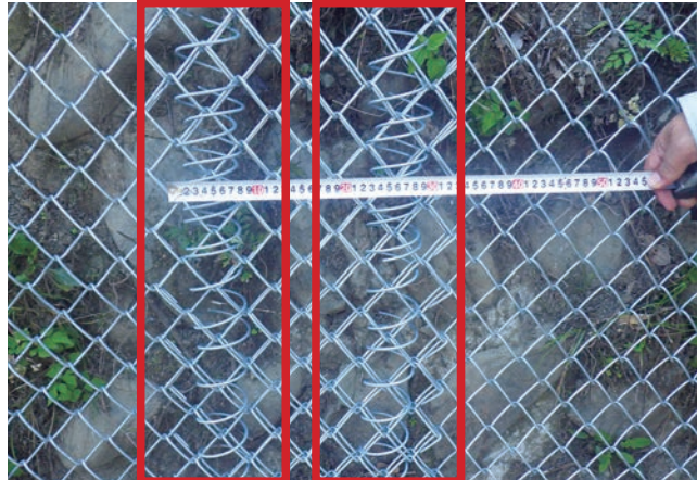
金網重ね部の結合コイル配置 (ネットタイプ共通)
