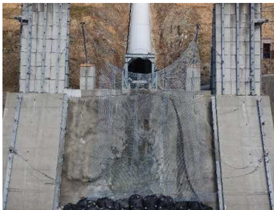
捕捉誘導後の全景
