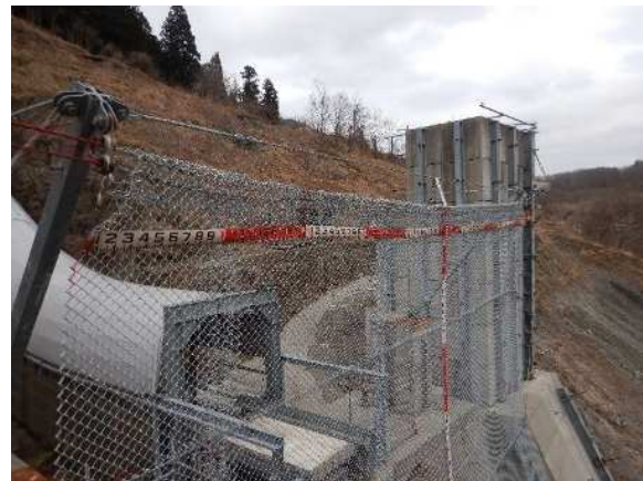
阻止面上端復旧状況
