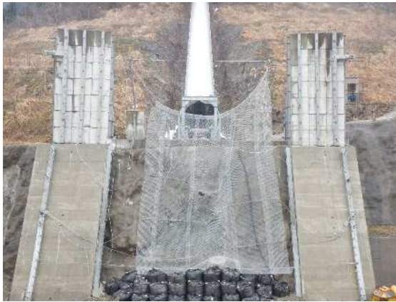
捕捉誘導後の全景
