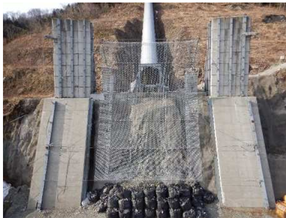
実験供試体全景
