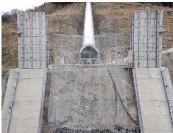
実験供試体全景
