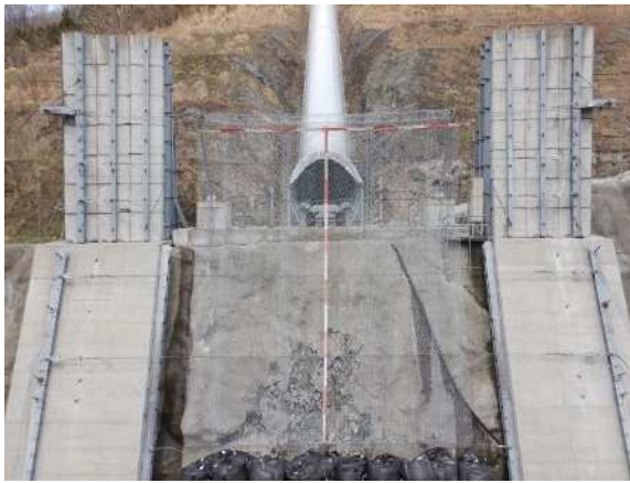
実験供試体全景
