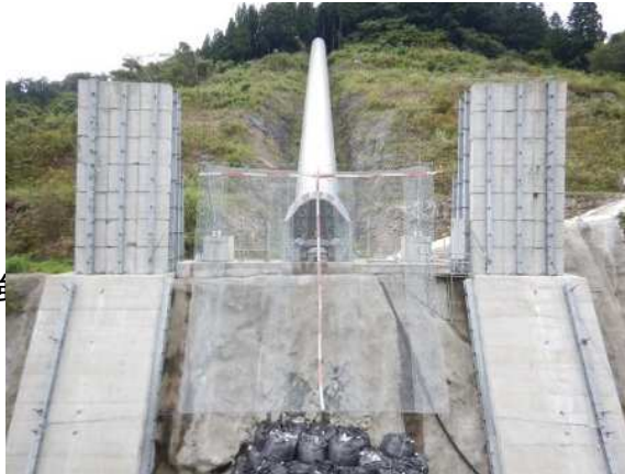
実験供試体全景
