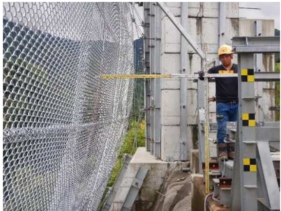
重錘衝突位置確認
