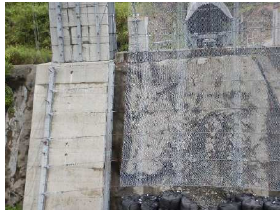
高強度金網修復部
