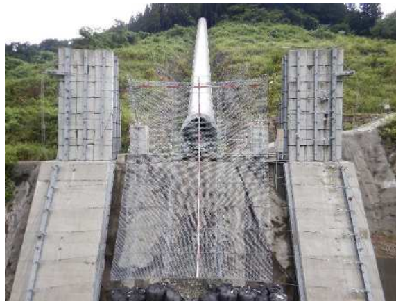
実験供試体全景
