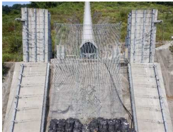
実験供試体全景
