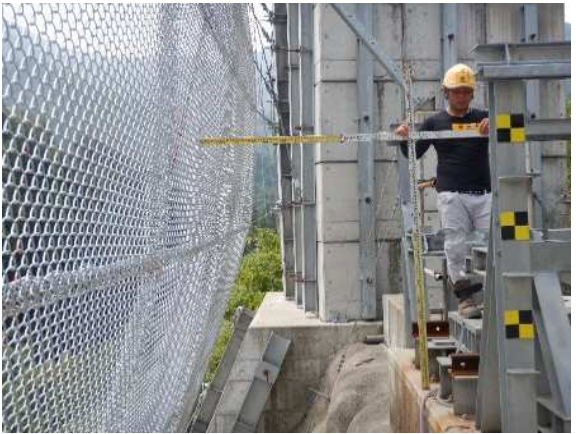
重錘衝突位置確認
