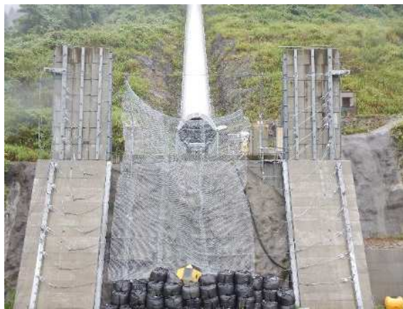
捕捉誘導後の全景
