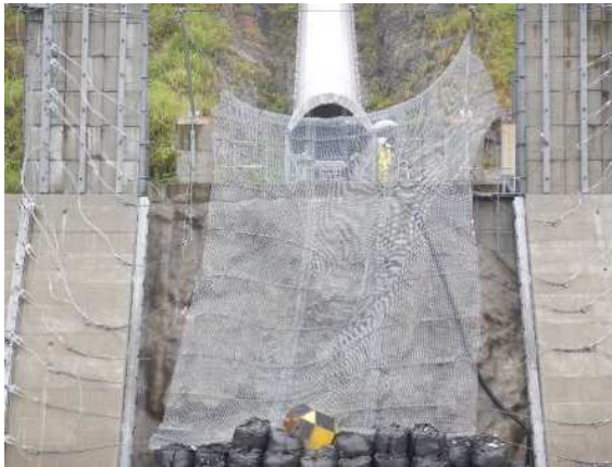
捕捉誘導後の全景
