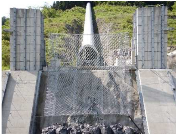
実験供試体全景
