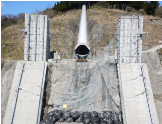
捕捉誘導後の全景
