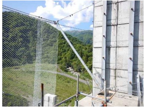
支柱設置状況
