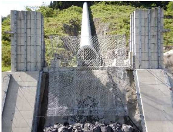
実験供試体全景
