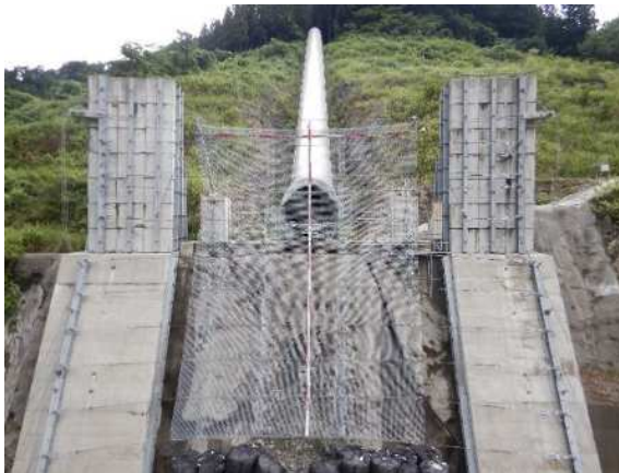
実験供試体全景
