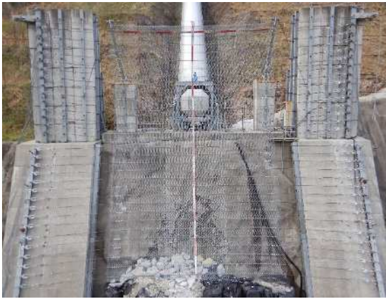
実験供試体全景
