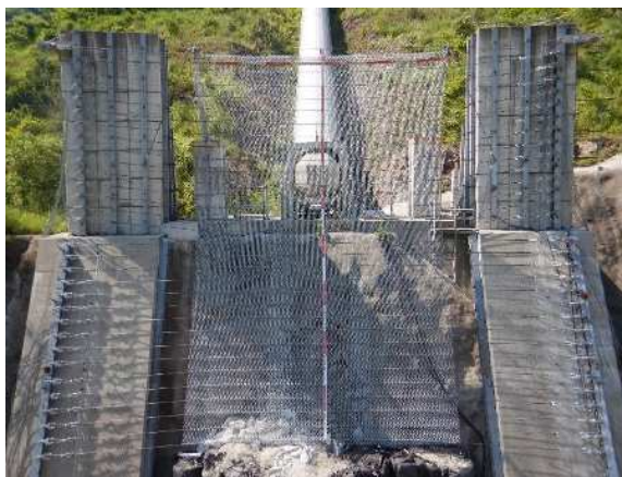
実験供試体全景
