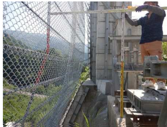
重錘衝突位置確認
