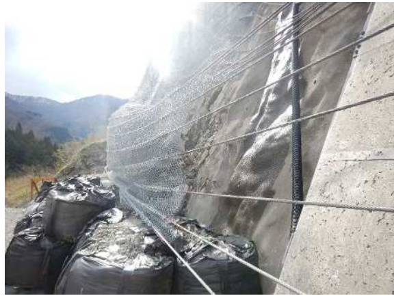
重錘捕捉状況
