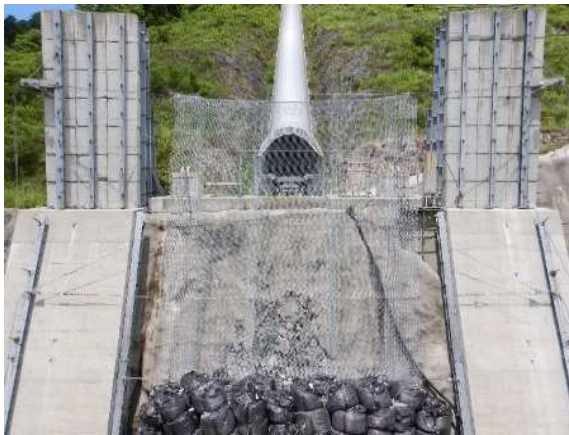
実験供試体全景
