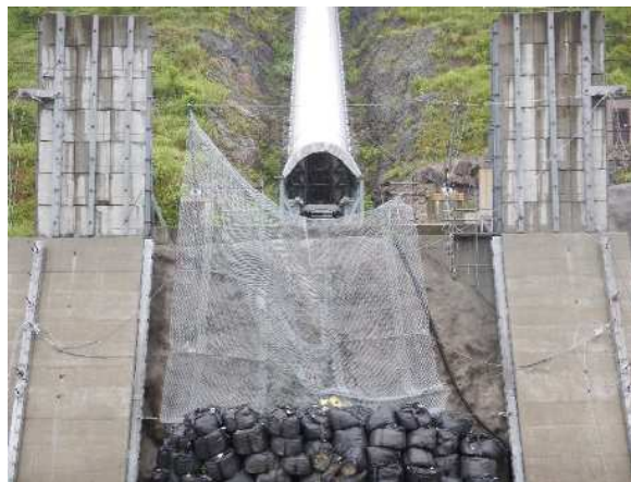
捕捉誘導後の全景
