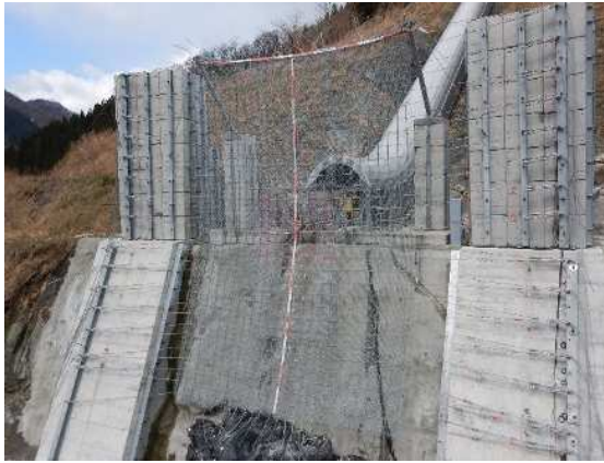
実験供試体全景
