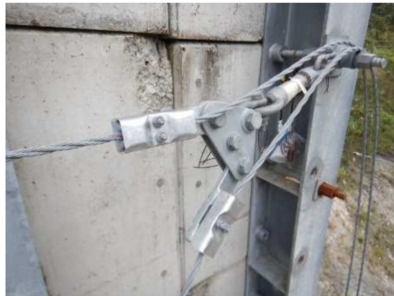
緩衝装置設置状況
