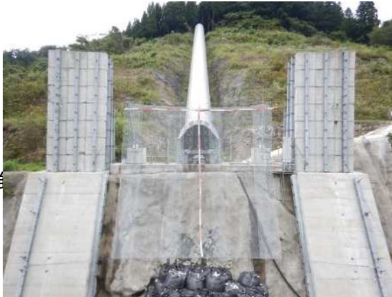
実験供試体全景
