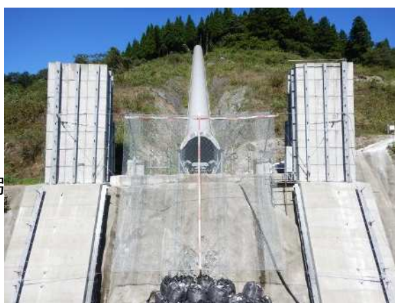
実験供試体全景
