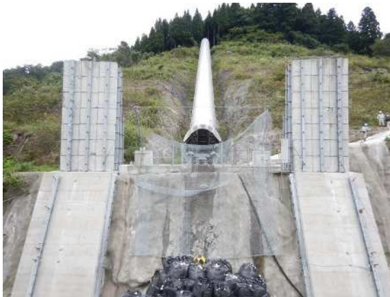
捕捉誘導後の全景
