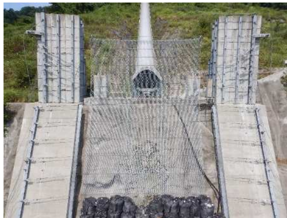
実験供試体全景
