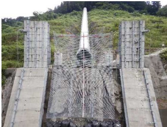
実験供試体全景
