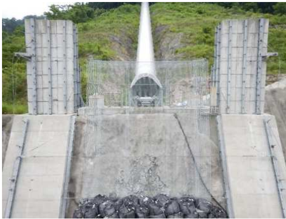
実験供試体全景
