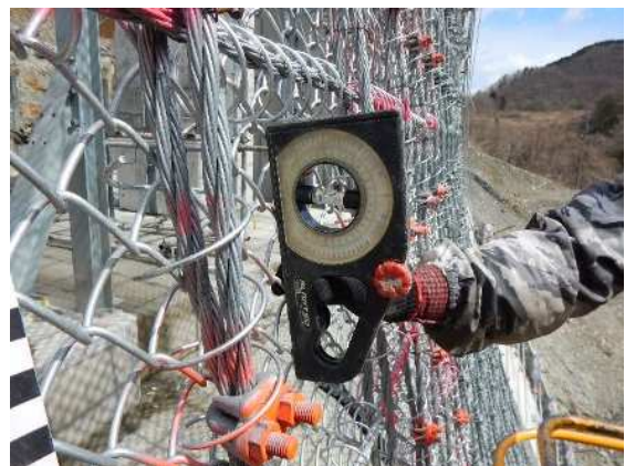
重錘設置角度確認
