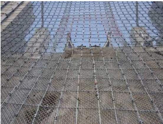
阻止面修復完了
