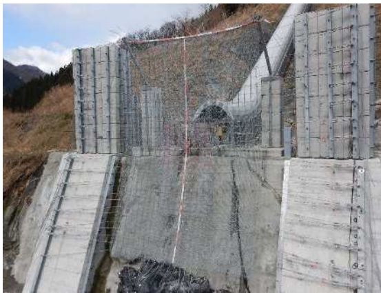
実験供試体全景
