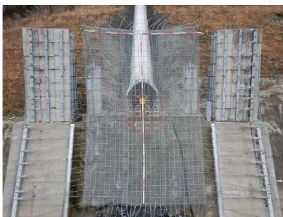
実験供試体全景
