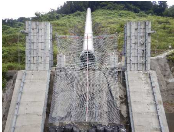
実験供試体全景
