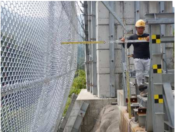
重錘衝突位置確認
