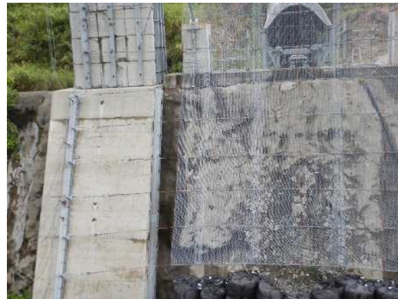
高強度金網修復部
