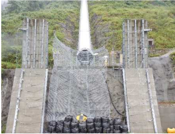
捕捉誘導後の全景
