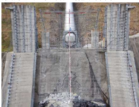
実験供試体全景
