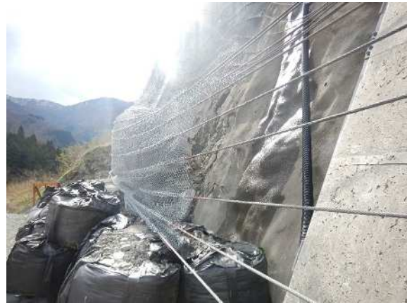
重錘捕捉状況
