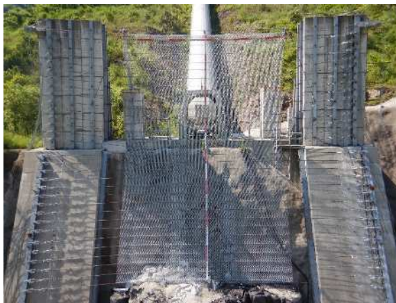
実験供試体全景
