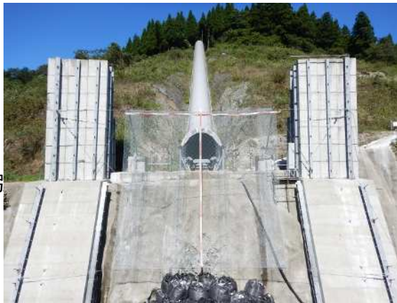
実験供試体全景
