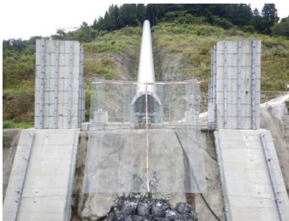
実験供試体全景
