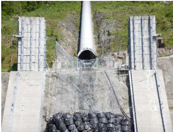
捕捉誘導後の全景
