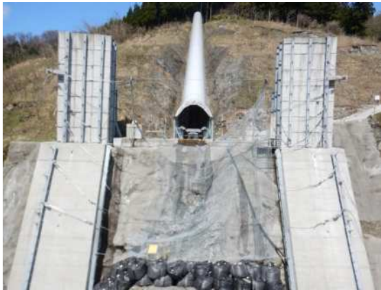
捕捉誘導後の全景
