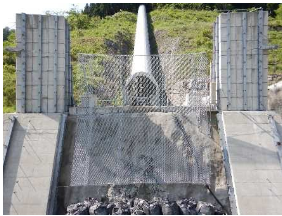
実験供試体全景
