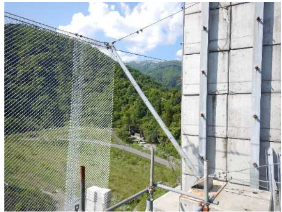
支柱設置状況
