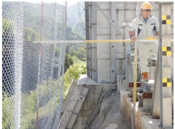
重錘衝突位置確認
