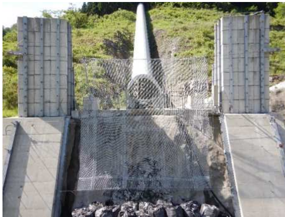
実験供試体全景
