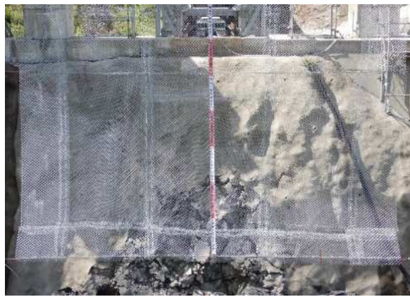
阻止面下端補修状況
