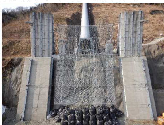
実験供試体全景
