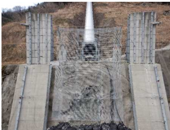
実験供試体全景
