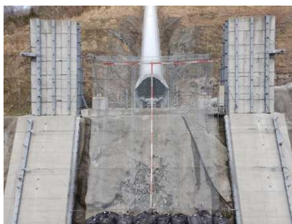
実験供試体全景
