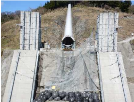
捕捉誘導後の全景
