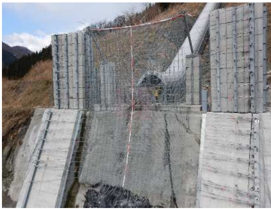
実験供試体全景
