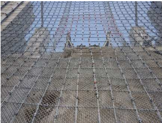
阻止面修復完了
