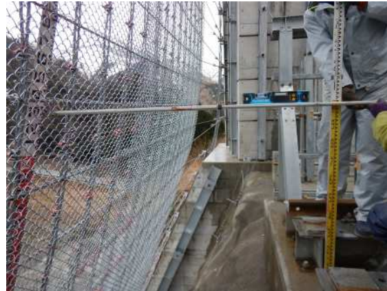
衝突位置確認状況
